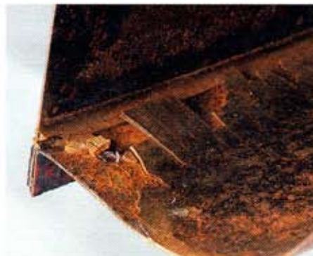
Fertans neues Nanoprodukt NT10 lagerte sich am Schwellerboden ab und bildete Risse
